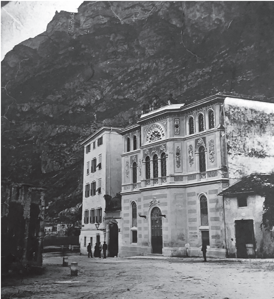
Fig. 1. Facciata del Teatro Sociale di Riva, 1878; ASCR
