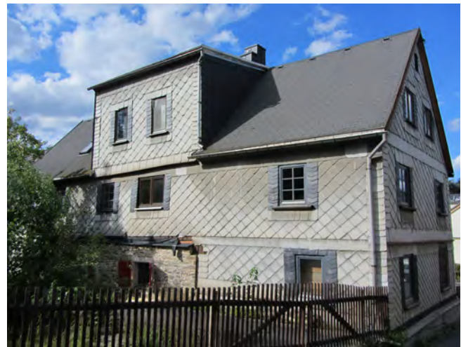
Abbildung 12: Ältestes in Markneukirchen erhaltenes Saitenmacherhaus mit ehemaliger Erker-Trockenstube: Bienengarten 12. Es beherbergte einst die Werkstätten von August und Wilhelm Voigt.
