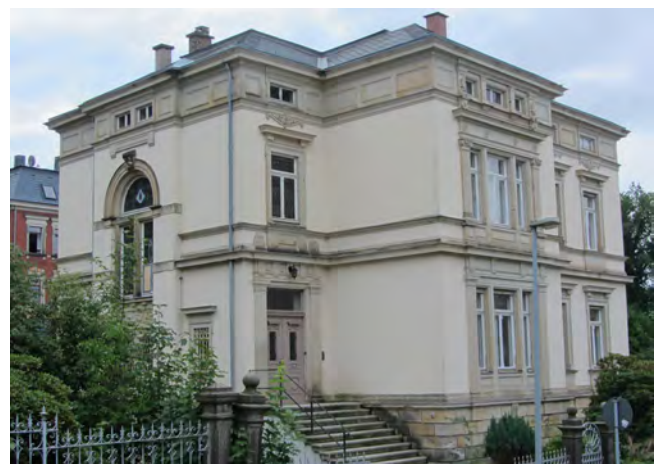
Abbildung 30 (von oben): Fotografie der 1889 gebauten Eckhaus-Villa von Richard Adler (Bismarckstraße 2)
