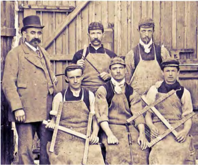
Abbildung 2 (oben): Trockendarmherstellung in einer Darmputzerei in Wales (um 1900) – ein Strang von ca. fünf geputzten Schafdärmen wird auf einen Holzrahmen gewickelt und dann luftgetrocknet (sitzend links: Saitenmachermeister Ernst Geipel sen. aus Markneukirchen)
