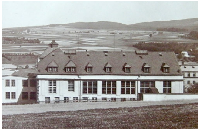
Markneukirchen, Wernitzgrüner Str. 38, E. Künzel & Co. Südseite, die großen Fenster wurden durch kleinere ersetzt
